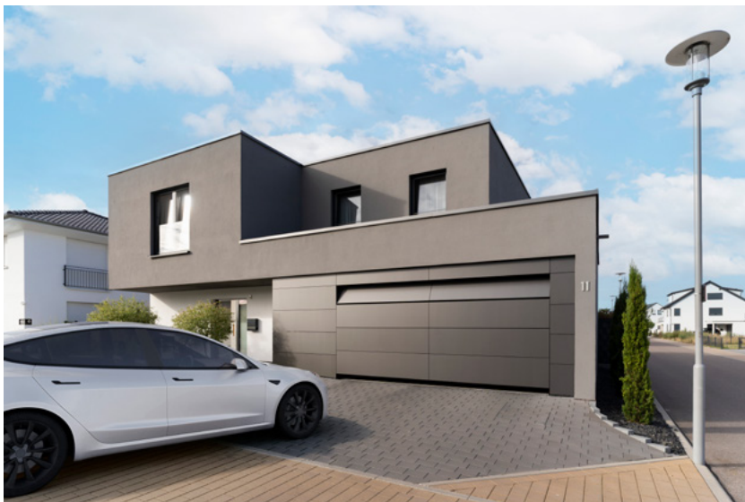
▲ Brama ALR F42 zlicowana z fasadą, z wypełnieniem wykonanym przez inwestora.
